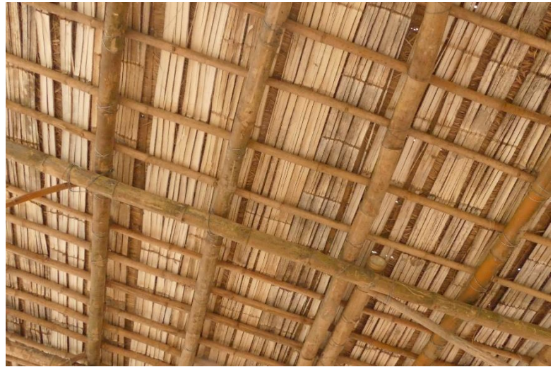
圖7. 柱仔腳厝屋頂的竹結構。
